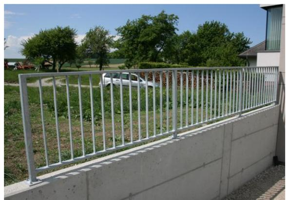
**Abbildung 13: Prinzip-Beispiel für eine Umwehung: allerdings sollte die Montage nicht auf, sondern von vorne an den Mauern erfolgen. Die mechanische Stabilität ist dann deutlich höher.**
