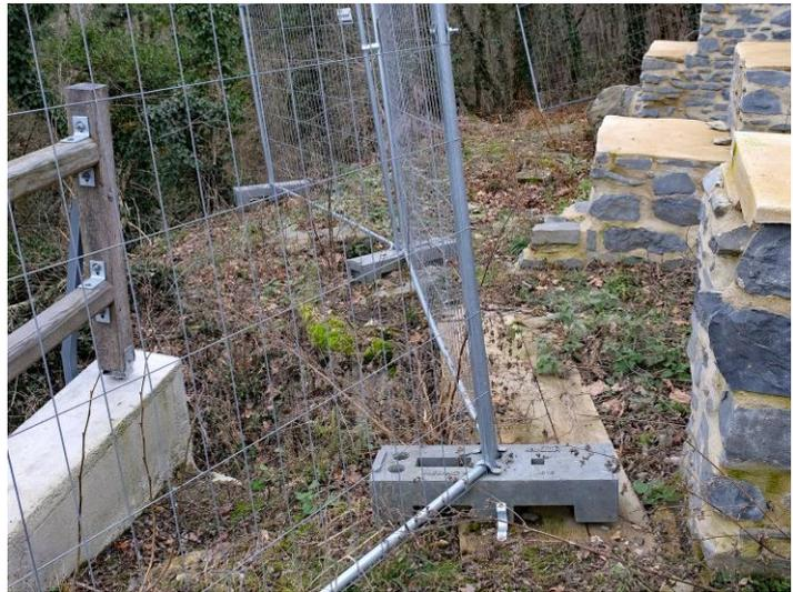
**Abbildung 9: aktueller Zustand: das Ende der Spritzbetonwand liegt offen, ohne Anschluss an die Fundamente der Umfassungsmauer. Diese befinden sich unter dem hintersten Bauzaun.**
