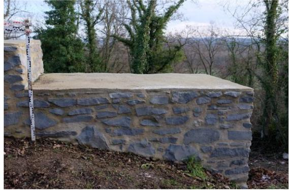
**Abbildung 6:** Beispiel für das Problem der variierenden Brüstungshöhe in Hanglage. An der Position der Messlatte beträgt die Brüstungshöhe der niedrigeren Stufe 45 cm, der höheren Stufe 80 cm. Auf der Rückseite ist die Fallhöhe > 3 m. Damit wird eine zusätzliche Umwehrgung zwingend erforderlich. Bei der Fallhöhe von unter 12 m muß ihre Oberkante mind. 0,9 m über der Lauffläche liegen.
