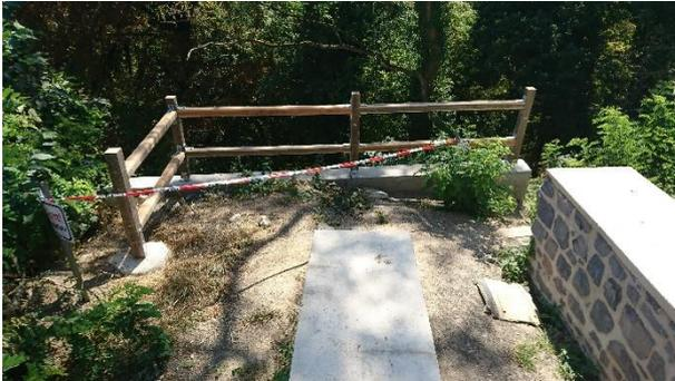
Abbildung 2: Absturzsicherung an der Spritzbetonwand am 02.08.2019. Die Höhe der Querholme, gemessen von der Oberkante der Betonwand beträgt 1,03 m; die geforderte Mindesthöhe von 1,10 m wird nicht erreicht. (Foto: Andreas Herrmann).
