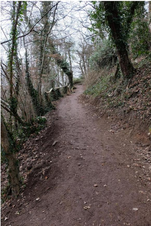
**Abbildung 8:** Aufweg, von Kehre 3 aus gesehen. Das Wegeprofil wurde leicht begradigt, eine Deckschicht fehlt. Im weiteren Verlauf steht der Rest alter Geländer. Durch den weiten Abstand der Pfosten zueinander biegen sich die Querholme bei Belastung durch: eine wenig vertrauenserweckender Zustand.
