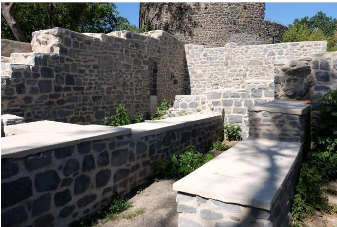
Abbildung 5: Aus rechtlicher Sicht eindeutig eine „waldtypische“ Situation. Zudem regt die flache Abdeckung der Mauerzüge zum Besteigen an. Die Fallhöhe in den inneren Kellerbereich beträgt bis zu 3.30 m.
