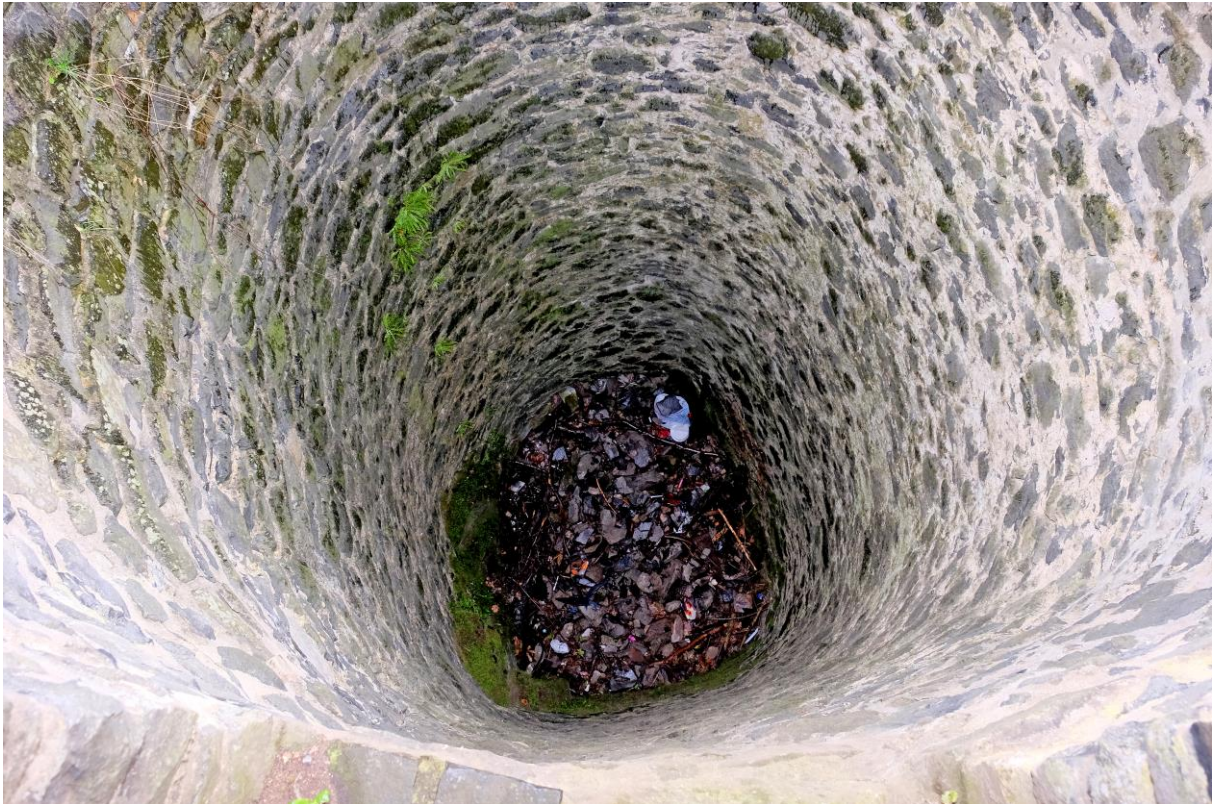
Brunnenschacht im April 2019.
