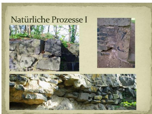
Niederschläge und Temperaturwechsel in den Frost hinein führen durch das sich beim Gefrieren ausdehnende Wasser zu einer „Frostspaltung“. Fugen werden verbreitert und am Ende steht der Verlust von Bausubstanz, hier: der Eckstein eines zu Beginn der 1970er Jahre hoch gemauerten Befundes, bereits verloren gegangene Steine am Türdurchgang zwischen Bergfried und Ofen sowie an den Fundamentsteinen des Bergfrieds.
