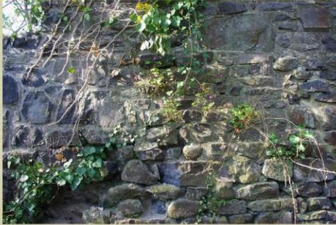
Aber auch biologische Vorgänge setzen dem Mauerwerk zu, hier beginnender Bewuchs auf der Ostseite einer Mauer neben dem Ofen. Die demineralisierende Wirkung feiner Wurzeln zermürbt den Fugenmörtel und ermöglicht dessen Auswaschung. Allerdings sind Fugen bevorzugte Standorte trockenliebender und durchaus schützenswerter Pflanzengesellschaften. Diese können zugelassen, sollten aber im Auge behalten werden. Aufstrebender Efeu sollte entfernt werden.
