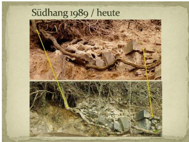
Auffällig ist hier eine über die Jahre unveränderte Lagerung z.B. des Ecksteines rechts, aber auch eine deutlich fortgeschrittene Unterhöhlung des Hanges unter den Wurzeln.
