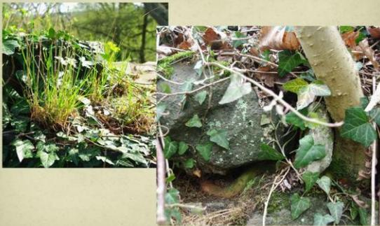
Werden die Pflanzen größer, vergrößert sich auch die Gefährdung. Wird größerer Bewuchs in die Höhe zugelassen (rechtes Foto) entwickeln Zweige und Blattwerk eine Windlast. Der Wind entwickelt über den Hebel der Stämme große mechanische Kraft und reißt Steine oder ganze Mauerpartien aus ihrem Verband.
